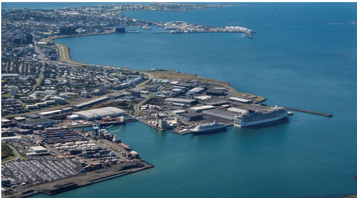
MYND 2.2 Yfirlit yfir hluta framkvæmdasvæðisins. Stærsta landsfyllingin verður að fylla upp í innskotið fyrir miðri mynd. Á myndinni er unnið að gerð Sundabakka.
